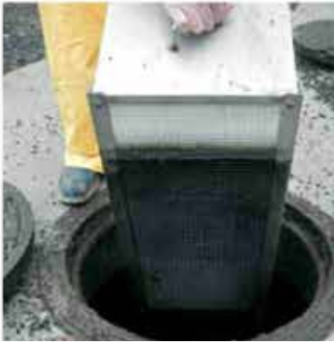
Adım 1: Koaliser filtre kolayca çıkarılır.
