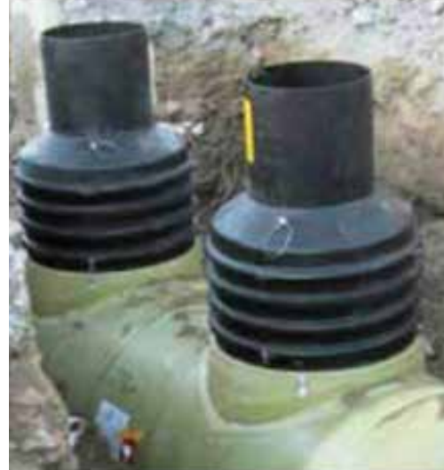
Şekil 6: EuroHUK 600 muayene bacası uygulaması
